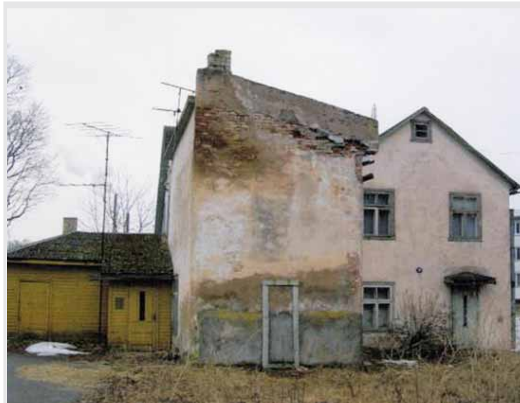
KINGITUS ÜHTEDELE, KOŠMAAR TEISTELE: Maja Lipuväljak 3a tagastati õigusjärgsetele omanikele koos üürnikega. Detsembris 2010 maja lammutati ja selle asemele kavatakse ehitada uus üksikelamu.
